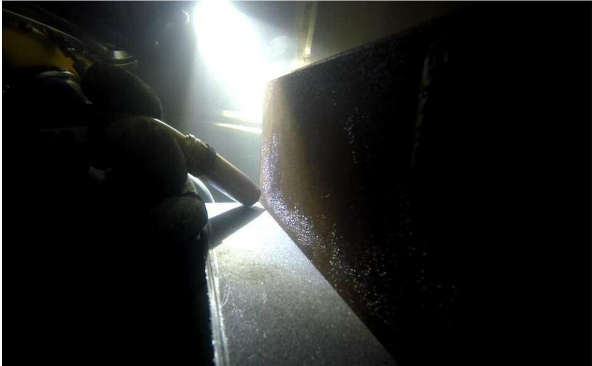
**Abbildung 3-33: Prozessevaluierung; Schweißtaucher beim Ansetzen des UW-MIG Brenners, Schweißposition: PB**
